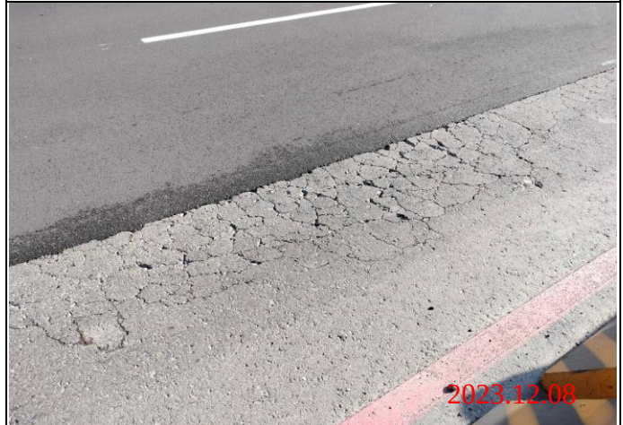
巡查日期地點：112.12.08/ Y23車站 照片說明：路面龜裂狀況
